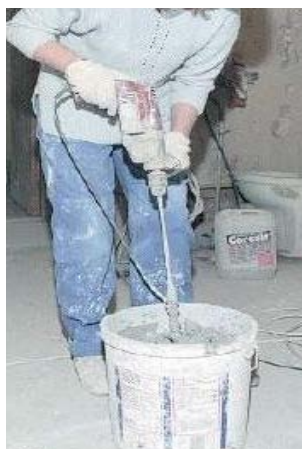
Рис 5.4. Приготовление строительного раствора из сухой смеси по рецептуре (состав № 2) с помощью электрического смесителя и выравнивание при устройстве основания под полы
