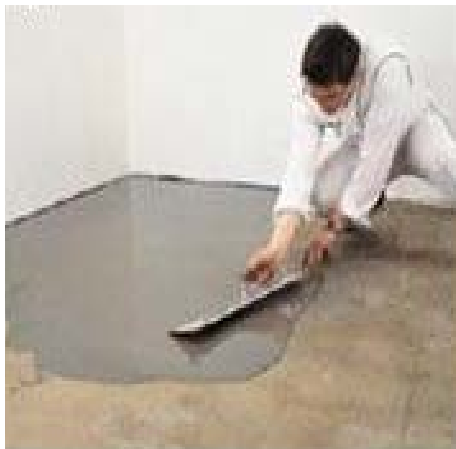
Рис 5.4. Приготовление строительного раствора из сухой смеси по рецептуре (состав № 2) с помощью электрического смесителя и выравнивание при устройстве основания под полы
