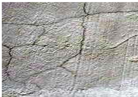
Рис. 3.2. Внешний вид строительного раствора с усадочными трещинами
